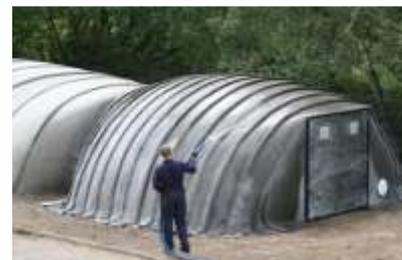
ancorata la struttura al suolo, inizia la fase di idratazione con acqua
