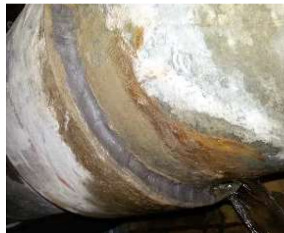
si procede con la sigillatura idraulica con il Putty lungo tutta la circonferenza
