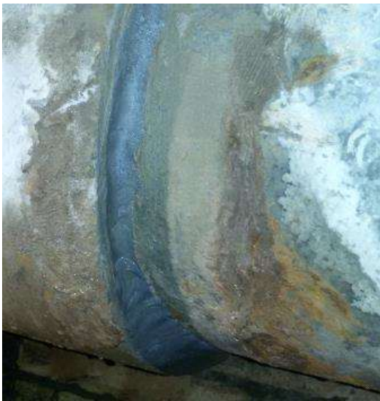
chiusura idraulica della perdita con Putty
