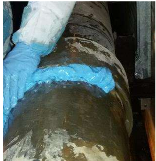
applicazione di Euro-Sub per prevenire future perdite e per eliminare lo scalino del manicotto
