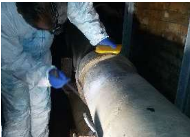
la prima operazione consiste nella pulizia dell'area interessata dall'intervento
