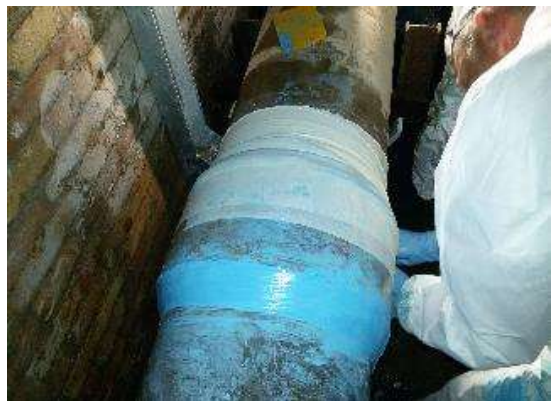
si avvolge tutta l'area dell'intervento con SG
