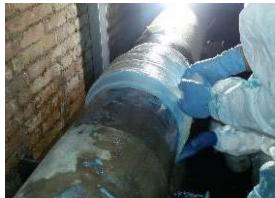
SG polimerizza in 20minuti circa e può contenere fino a 20 bar
