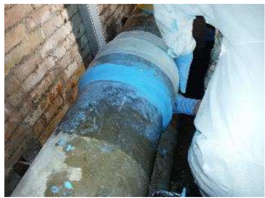
si passa alla fase finale (parte meccanica)
