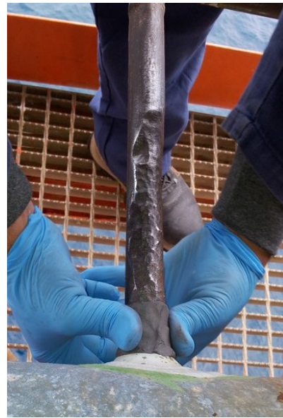
Ricostruzione con putty Syntho Steel
