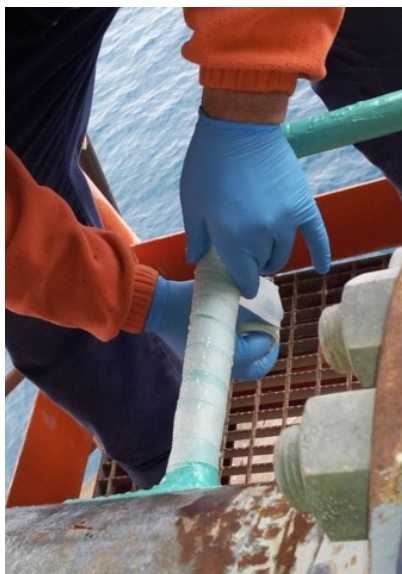
Applicazione 1 strato Syntho-Glass XT
