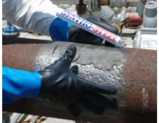
2) applicazione di Syntho Steel Putty : nelle aree maggiormente degradate o con presenza di fori, applicare il bicomponente Syntho Steel Putty. Questo materiale, una volta indurito, assume la consistenza dell'acciaio e serve a ricreare spessore nella parete del tubo e per ridare corpo alla tubazione ormai degradata.
