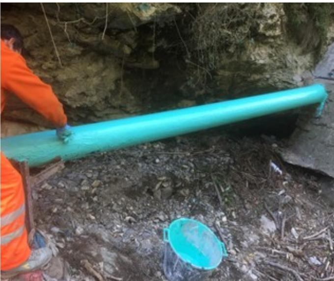
3) applicazione Sub-Sea LV : applicare Sub-Sea LV (fibre di kevlar e polimero) per garantire la tenuta idraulica su tutta la superficie deteriorata della condotta e per proteggerla da future aggressioni chimiche. Il prodotto può essere applicato anche su superfici umide purchè sia garantita l'interruzione della pressione
