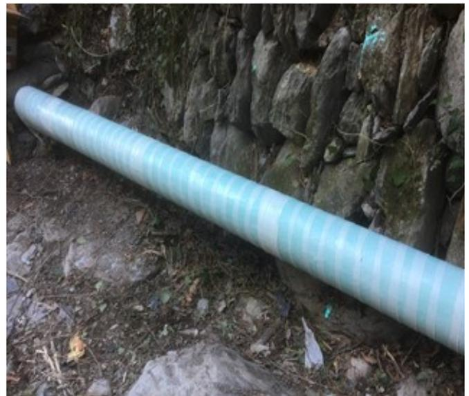
4) fasciatura meccanica con Syntho-Glass : la quarta ed ultima fase, consiste nel ricostruire meccanicamente il tubo grazie all'applicazione di Syntho-Glass, una fasciatura che dona una estrema resistenza meccanica alla condotta; in particolare verranno rinforzati/fasciati tutti i punti di saldatura, le curve e gli innesti laterali .
