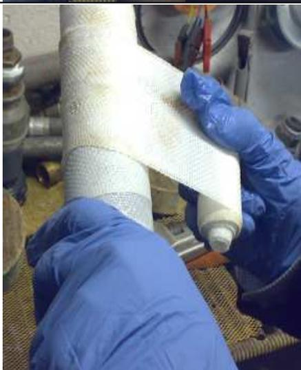
Utilizzate tutta la fascia a disposizione nel kit, strizzate e modellate la fasciatura ad ogni giro in modo da rimuovere eventuali eccessi di acqua. Per rendere la superficie esterna più liscia, appena terminata l'operazione di avvolgimento di Synto Glass, prendere il film in polietilene in dotazione ed avvolgerlo intorno alla fasciatura. Trascorso il tempo di maturazione, la condotta può tornare in esercizio (max 20 bar).
