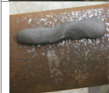
Posizionare il Putty sulla zona oggetto dell'intervento o in prossimità della stessa (in caso di perdita attiva). Prendere il nastro di contenimento in dotazione ed avvolgerlo prima sull'area adiacente all'intervento per ancorarlo e successivamente avvolgerlo sulla zona dove precedentemente è stato posizionato il Putty
