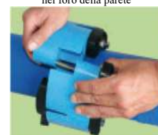
posizionare il giunto sul tubo e unirlo
