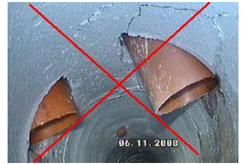
problemi dovuti ad innesti laterali senza T-flex
