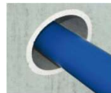
centrare la canalizzazione nel foro della parete
