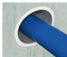
centrare la canalizzazione nel foro della parete
