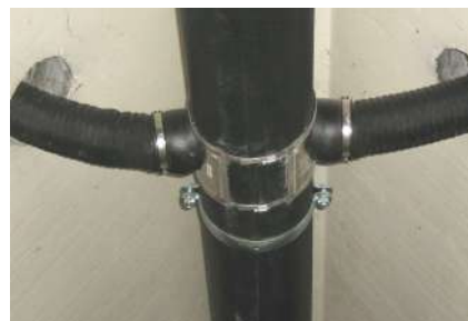
applicazione doppio T-flex su tubi PE
